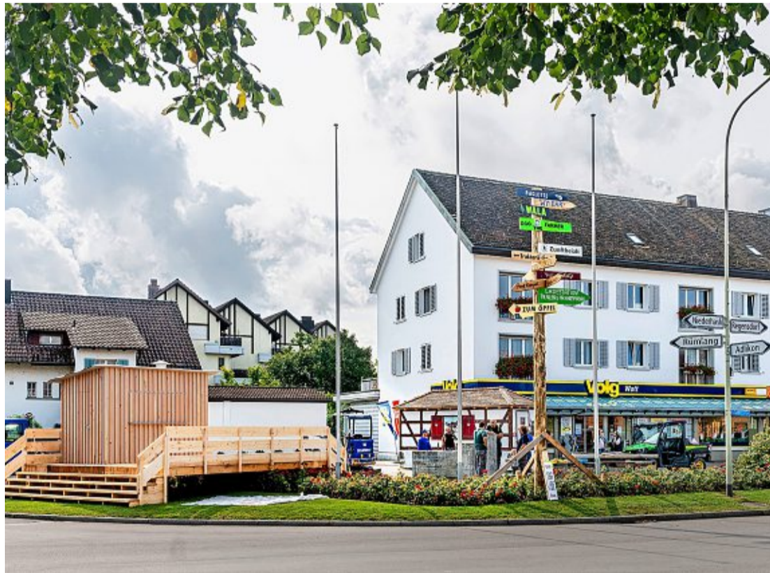
Auf dem Watter Dorfplatz laufen die Aufbauarbeiten fürs Watterfäscht auf Hochtouren. Foto: Leo Wyden
